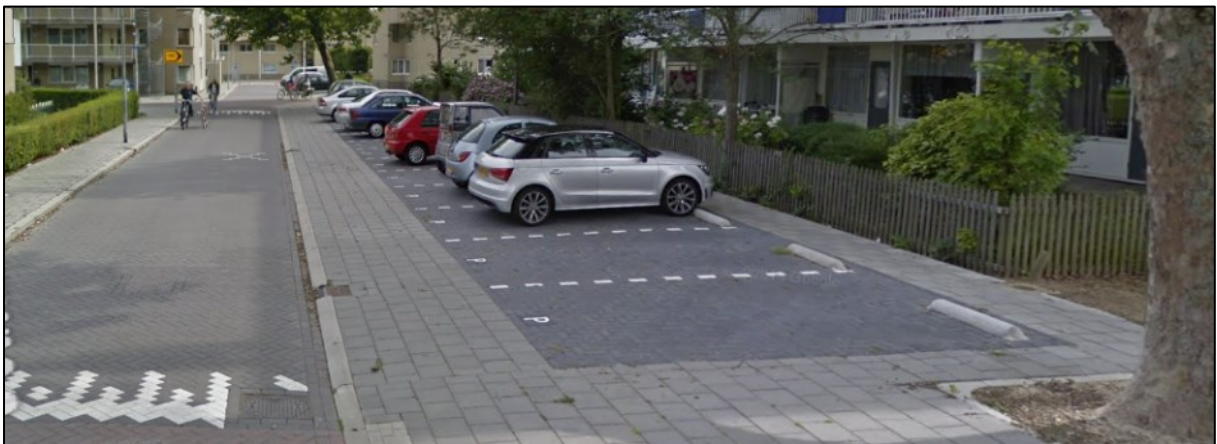
Figuur 4.12: Een voorbeeld van haaksparkeren met een verhoogde schuine band voor toegankelijkheid bij een plateau
