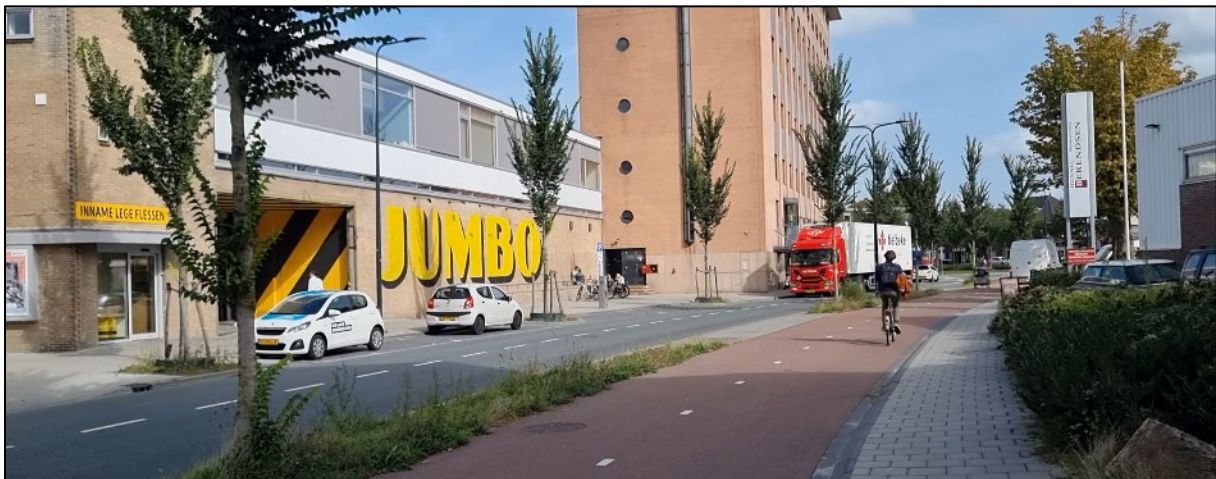
Figuur 4.1: Vrijliggend tweerichtingsfietspad langs de Raiffeisenstraat
