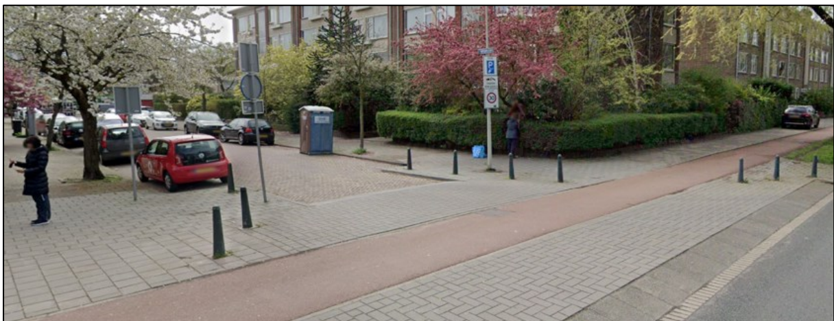
Figuur 4.2: In- uitritconstructie als overgang tussen een 30 km/uur-zone en een 50 km/uur weg, incl. vrijliggend eenrichtingsfietspad
