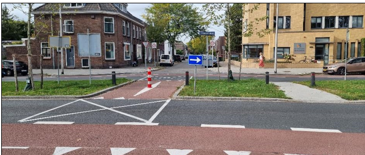
Figuur 4.9: Voetgangers steken over maar missen een verlaagde band en eindigen ter hoogte van een lichtmast.
